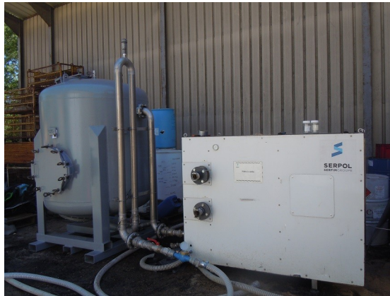
Station de traitement des eaux pompées
