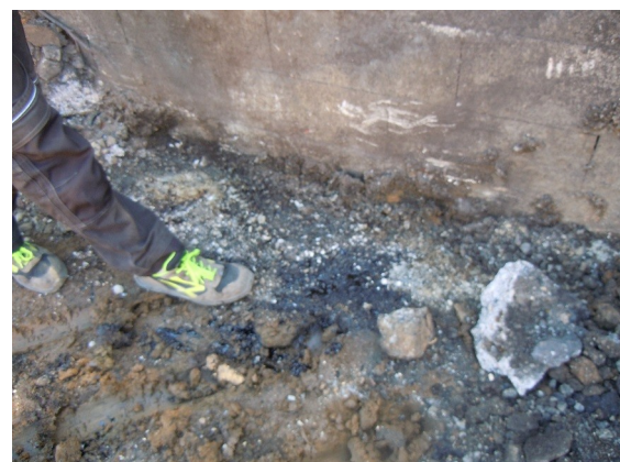
Présence d'hydrocarbures au pied du muret
