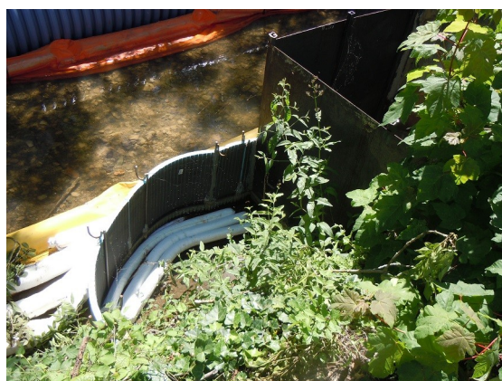
Batardeau renforcé au niveau du point principal de suintement dans la rivière « Le Sauzay »
