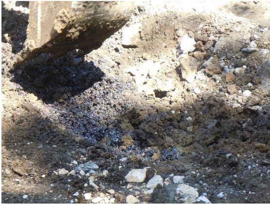
Zone en cours d'excavation située entre la rétention de la fosse et la dalle béton démantelées avec présence de liquide noir à environ 2,8 mètres de profondeur (remontée de la nappe)
